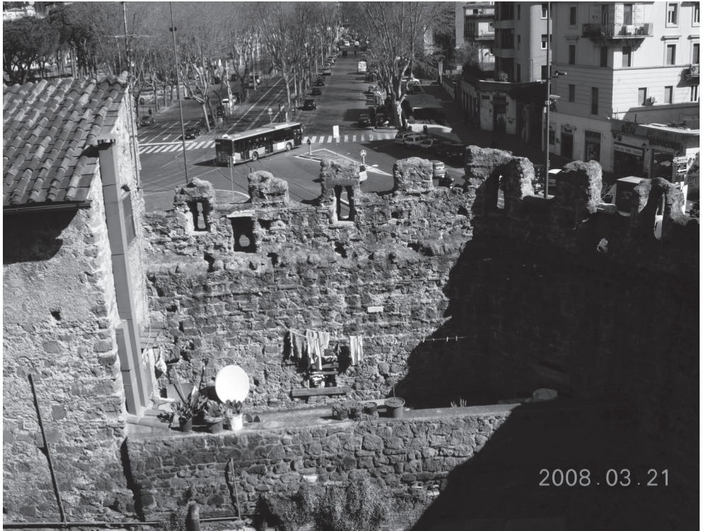
Fig. 11 - Braccio orientale della muratura altomedievale della corte interna di porta Ostiense. Si noti, sottostante alla merlatura, la traccia del piano di calpestio del cammino di ronda (foto a cura dell'autore).
