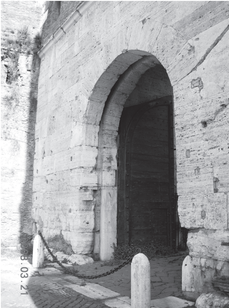
Fig. 6 - Particolare di porta Ostiense con il fornice d'ingresso. Si noti ancora il canale scavato nel travertino per ospitare la grata a caduta verticale di chiusura a saracinesca (foto a cura dell'autore).
