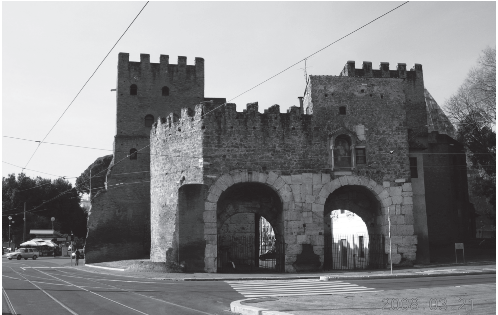
Fig. 2 - La porta Ostiense aperta verso la città con due fornici in uscita dalla corte interna (foto a cura dell'autore).
