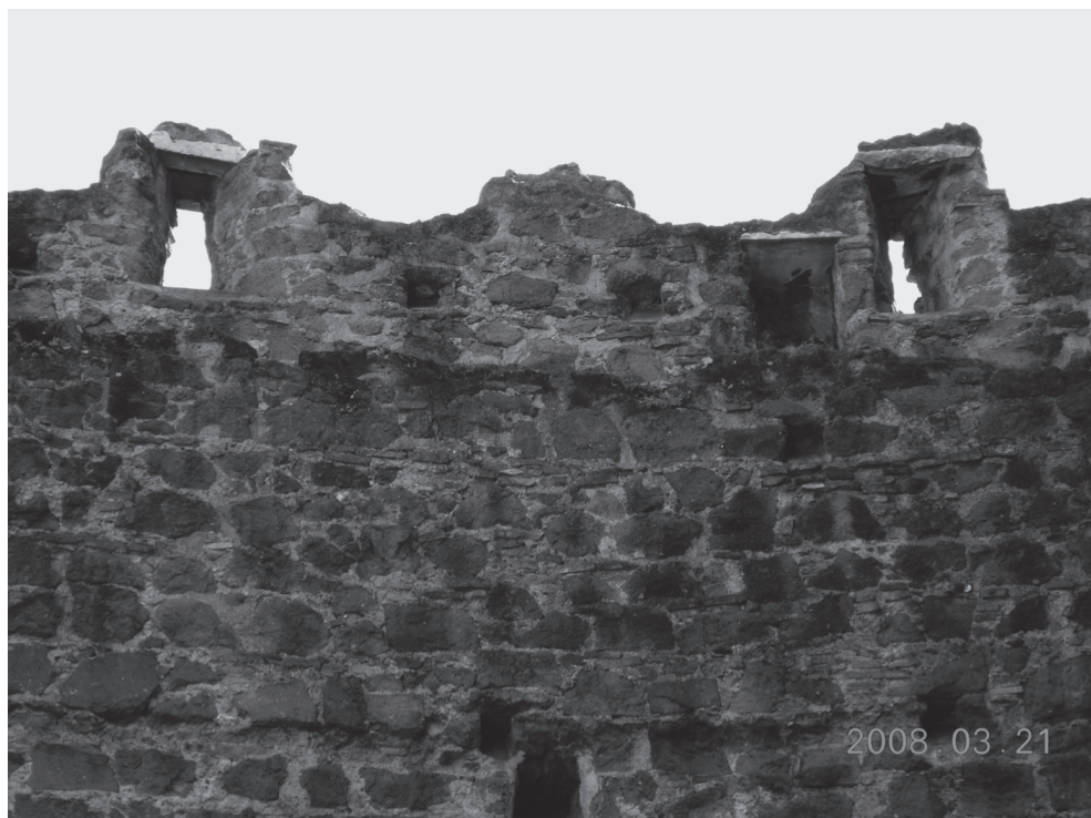
Fig. 12 - Particolare della merlatura interna a feritoia della corte interna di porta Ostiense (foto a cura dell'autore).
